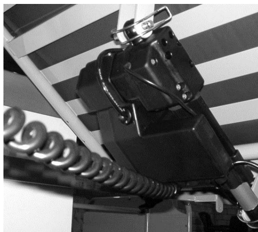
Obr. 14: položení síťového kabelu
